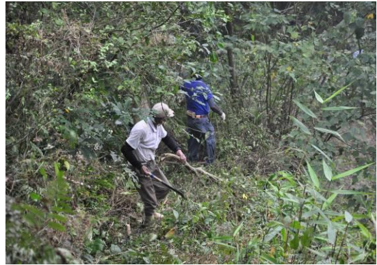
圖版 59：清理崩塌地頂端
