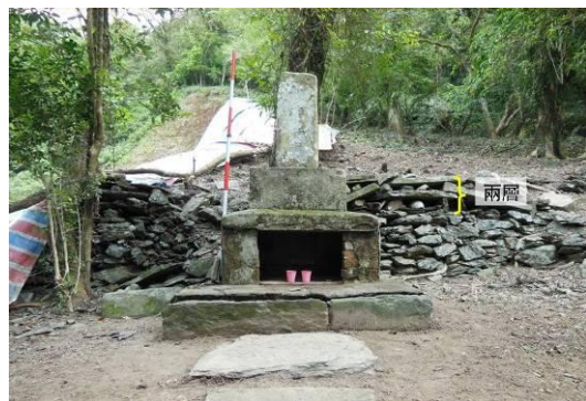
圖版 21：日治後期的人頭骨架石積式涵洞仍保留二層
