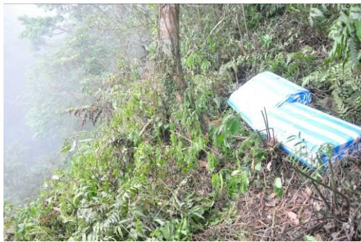
圖版 60：覆蓋崩塌邊坡之大型防水帆布
