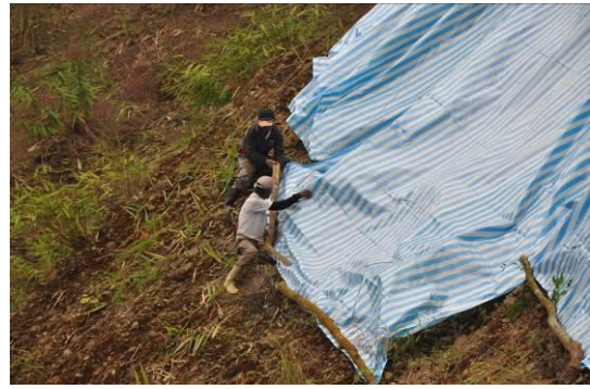
圖版 65：帆布下方以木條壓固，避免帆布遭地形風翻覆、雨水侵入崩塌地表
