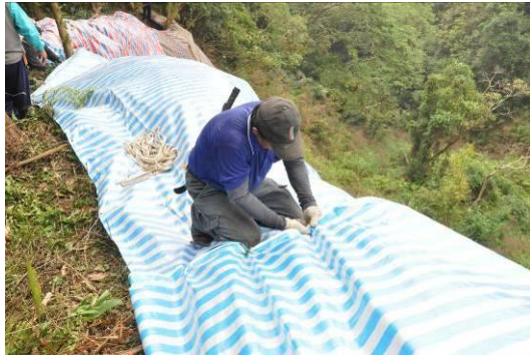
圖版 64：使用鐵絲、繩索拼接帆布，並將之固定於崩壁頂的樹木
