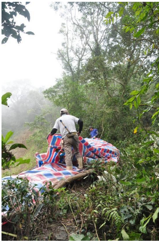
圖版 66：帆布覆蓋邊坡施工景象
